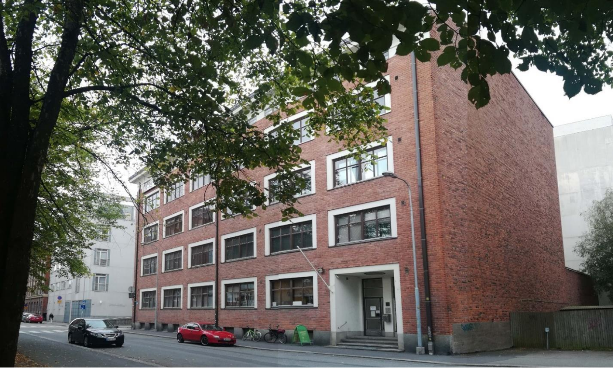
Kuva. Kahdesta kuvasta yhdistetty yhdistelmäkuva Salhojankadun julkisivusta. Julkisivu on järjestelmällisesti aukotettu Salhojankadun ja Tammelankadun suuntaan. Rakennuksen pohjoispuolinen tontin rajaan kiinnirakennettu pääty on umpinainen.
