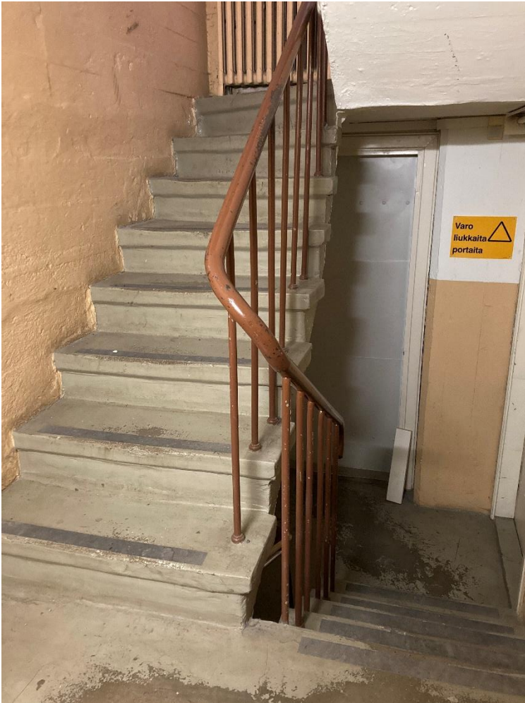
Kuva. Rakennuksen pienempi porrashuone on rakennusmassan sisäkulmassa. Portaikko on materiaaleiltaan ja ilmeeltään vaatimattomampi; portaat ovat maalattua betonia ja porraskaide terästä.
