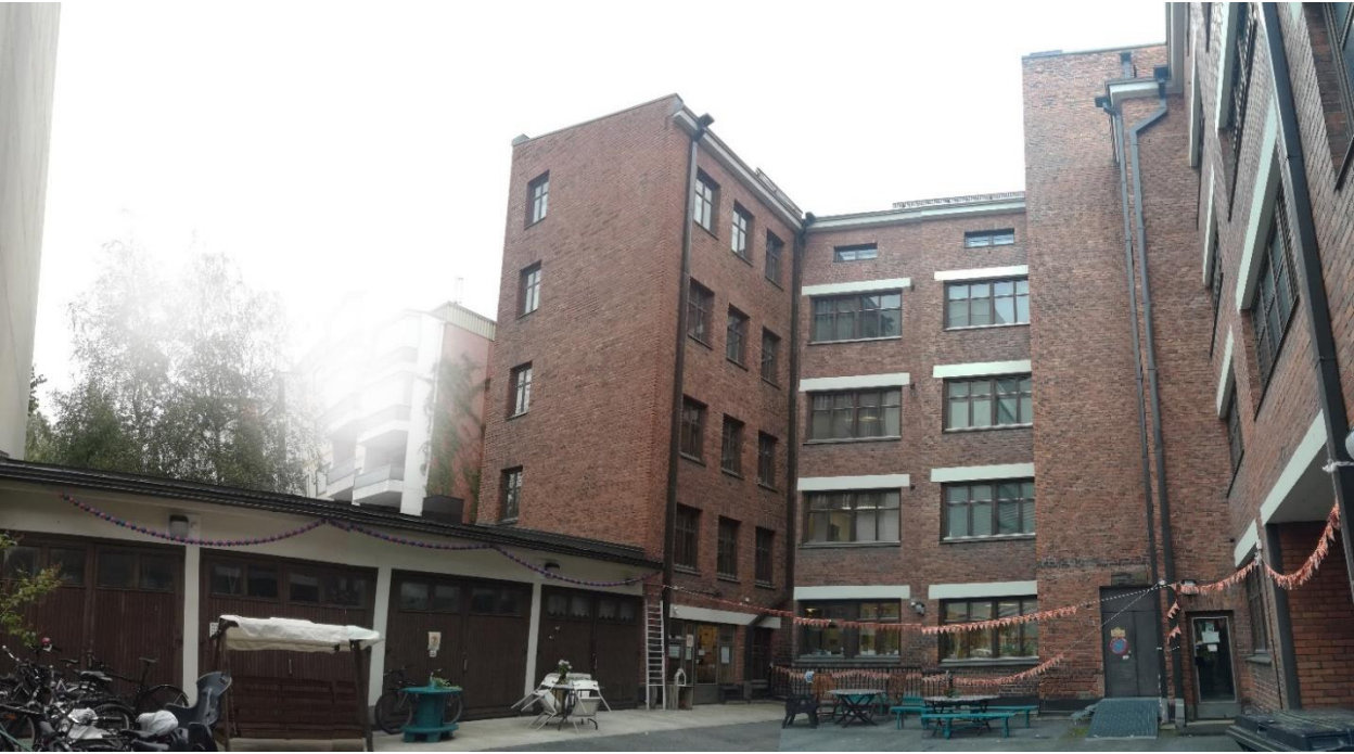
Yhdistelmä kuva sisäpihalta. U-kirjaimen muotoinen rakennusmassa luo tontin keskelle suojaisen sisäpihan. Autotallisiiven julkisivut on rapattu vaaleaksi. Sisäpihalle avautuvien tehdassalien ikkunoiden yläosassa on vaaleaksi maalattu rappauskenttä.
