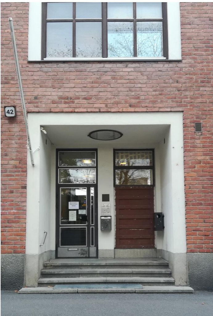
Kuva. Rakennuksen pääsisäänkäynti Salhojankadulla on sisäänvedetty julkisivupinnasta. Sisäänkäynnin seinä- ja kattopinnat ovat vaaleaa rappausta. Pääsisäänkäynnin alakattoon on upotettu pyöreä ulkovalaisin.
