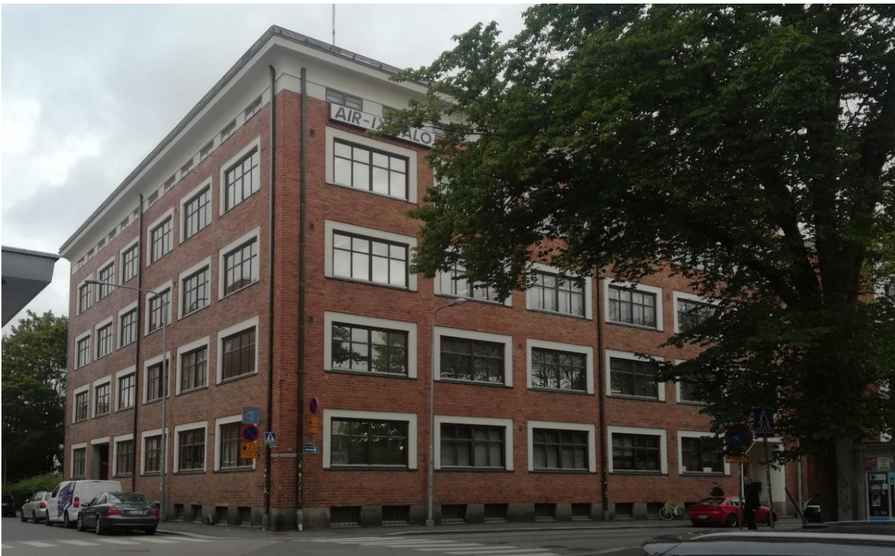
Kuva. Rakennuksen julkisivut Salhojankadun ja Tammelankadun risteyksen suuntaan.
